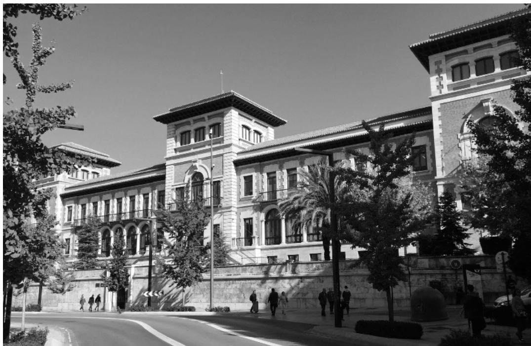
Fachada de la antigua Escuela Normal de Magisterio. Actualmente, Delegación de Gobierno y de Educación de la Junta de Andalucía. 2018
