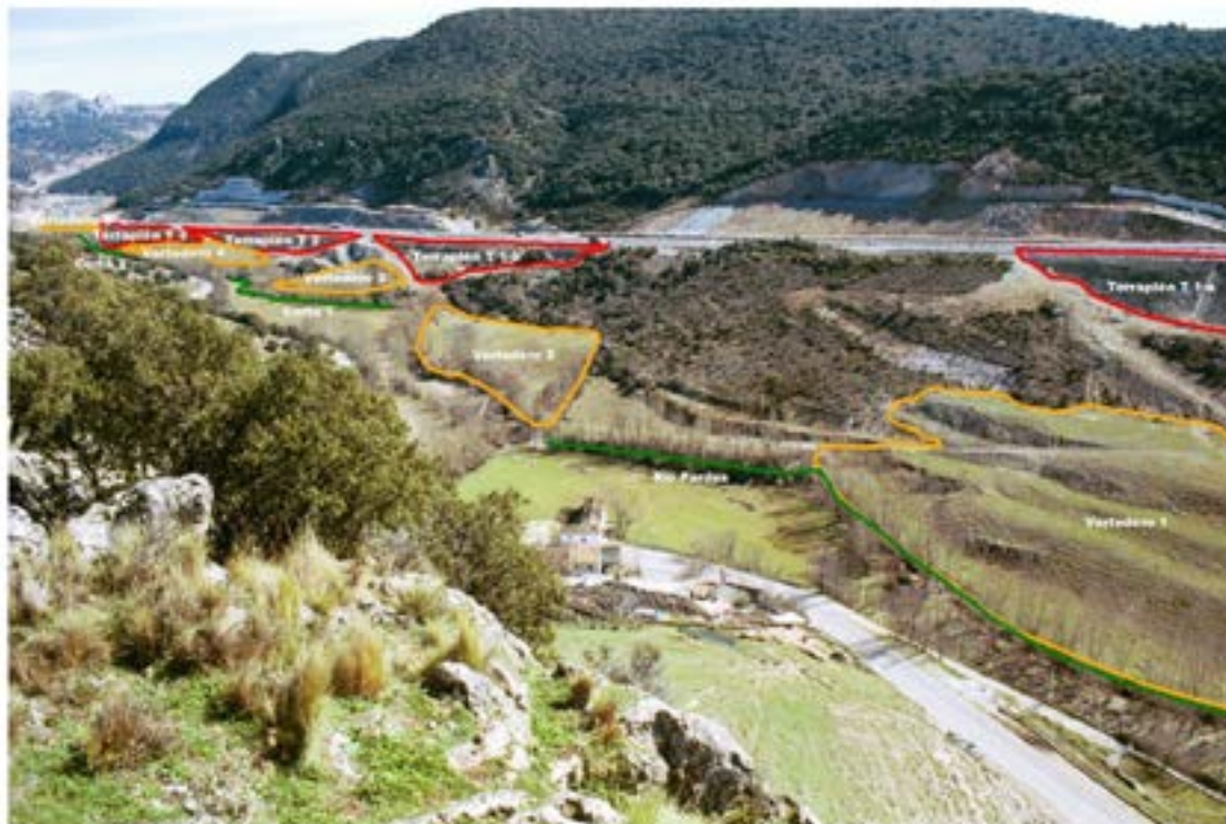
Figura 5. Autovía A-92 a su paso por el Parque Natural de la Sierra de Huétor. Ejemplo de restauración e integración paisajística. Fuente propia.
