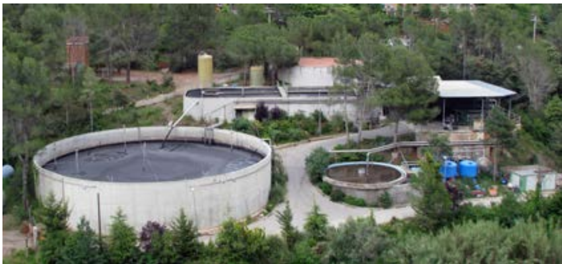
Figura 1. Estación depuradora de aguas residuales. Fuente: Xavigivax, CC BY-SA 3.0, https://commons.wikimedia.org/w/index.php?curid=5037944
