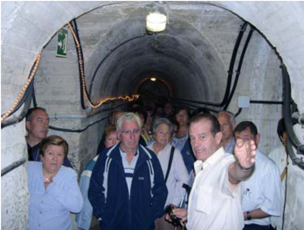
Alumnos de “El agua en la Naturaleza, del curso 2005/06, en los túneles del interior de la presa del embalse del Negatín, recibiendo explicaciones de un ingeniero de la Confederación Hidrográfica del Guadalquivir (25 de mayo de 2006)
