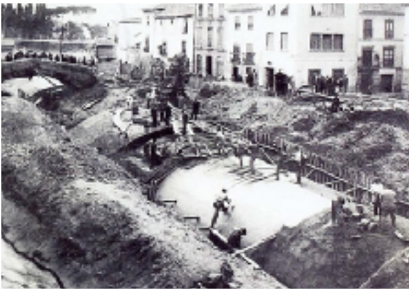
23. Embovedado del río Darro entre el viejo Puesto de la Virgen y su desembocadura en el río Genil. Fuente: http://porlascallesdegranada.blogspot.com/
