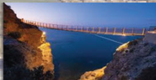
Pasarela colgante Torrenueva
